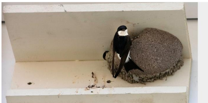
Huiszwaluwnesten aan de gevel.
