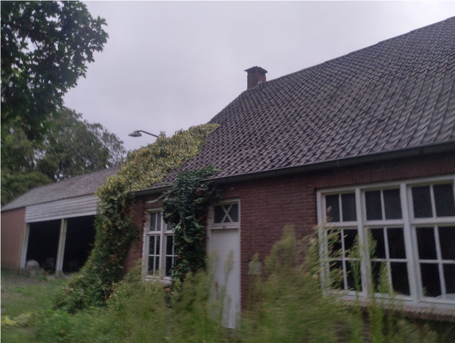
Op daken van de opstallen bevinden zich pannendaken die geschikt zijn voor huismussen. Foto: K.C. Fokker | Ecoresult B.V.
