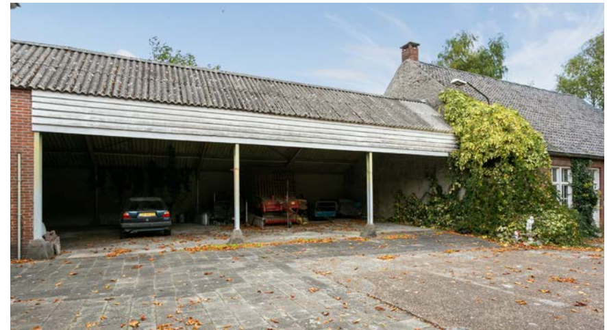
De gebouwen op het erf zijn vervallen en behoeven onderhoud en een nieuwe invulling voor duurzaam behoud van de cultuurhistorische waarden in de toekomst
