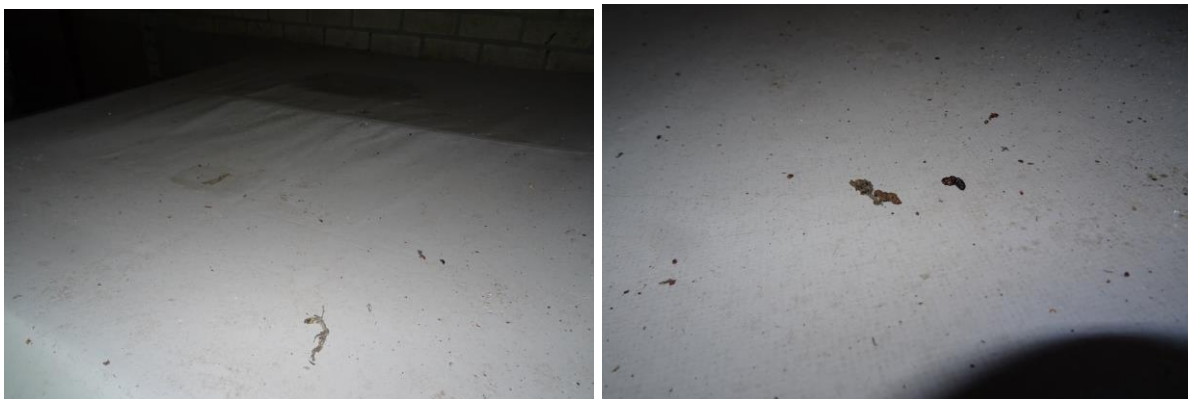
Afbeelding 17 t/m 20: sporen vleermuizen in de te slopen stal. Bron: BNL advies. Datum: 17-05-2022
