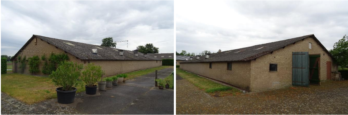
Afbeelding 5 en 6: Bestaande te slopen voormalige stallen en opslagloods. Bron: BNL advies. Datum: 17-05-2022
