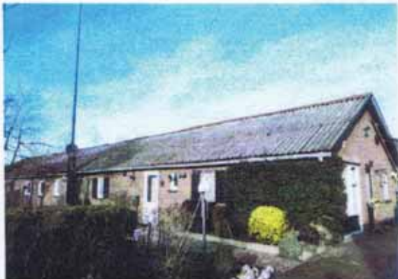
1 Aanzicht golfplatendak woning
