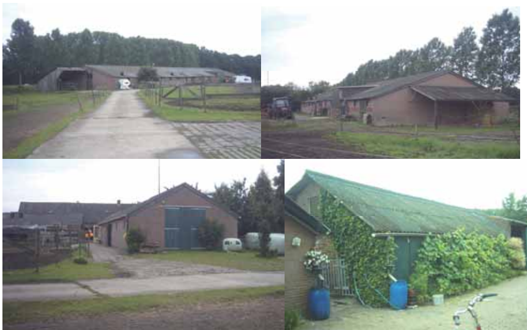
Figuur 13. Bedrijfsbebouwing ter plaatse.
