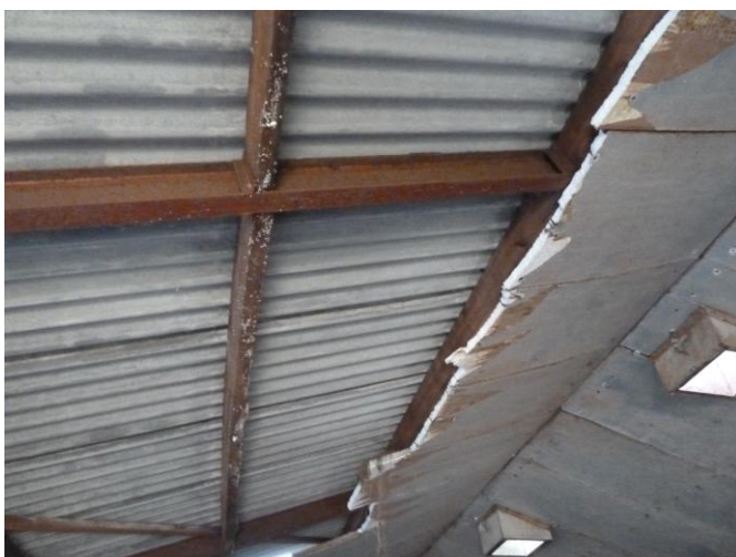
Detail binnenzijde dak te slopen varkensstal
