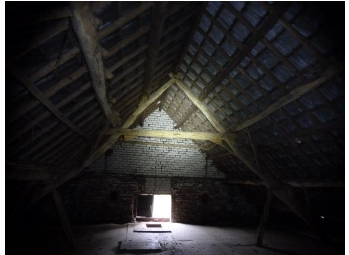
Hooizolder in de bedrijfswoning
