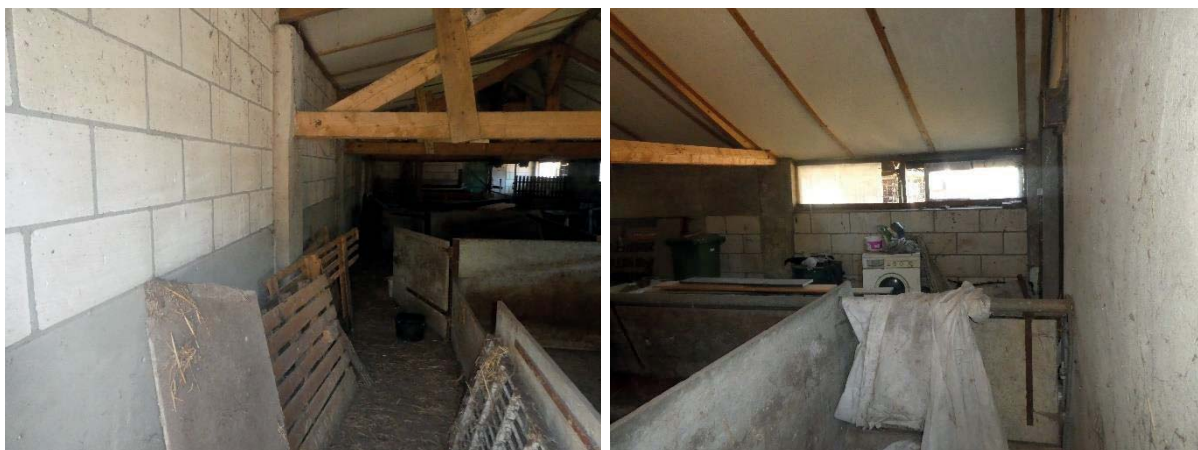
Afbeelding 15 t/m 20: Bestaande te slopen bebouwing. Bron: BNL advies. Datum: 14-06-2023
