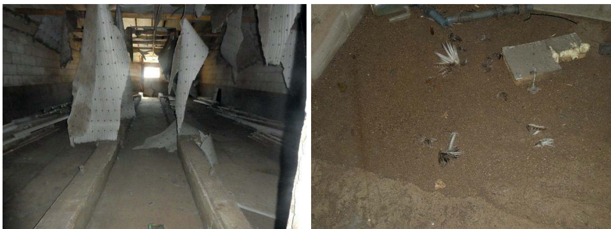
Afbeelding 3 t/m 8: Bestaande te slopen bebouwing. Bron: BNL advies. Datum: 14-06-2023
