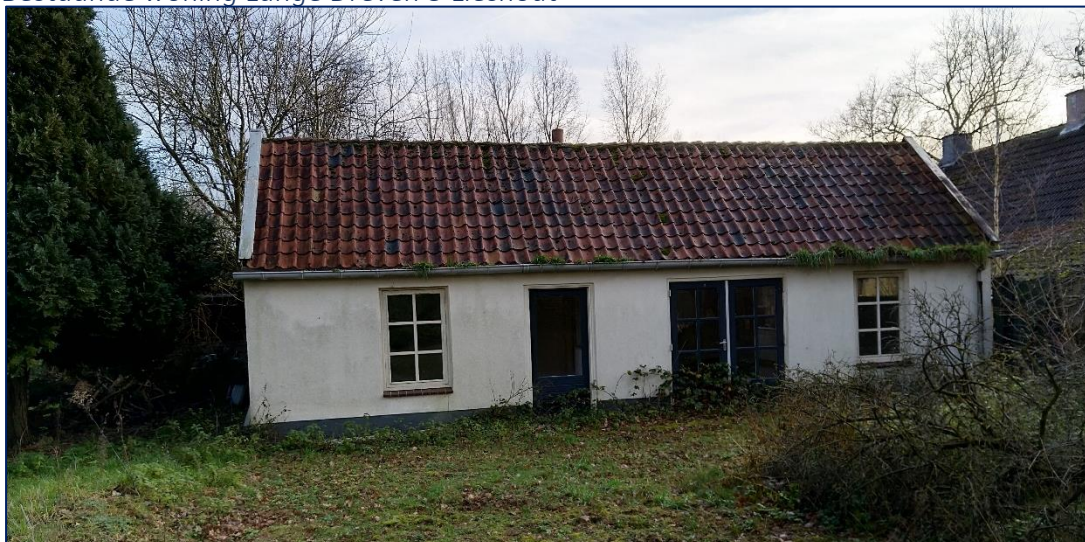
Bestaande woning Lange Dreven 3 Lieshout
