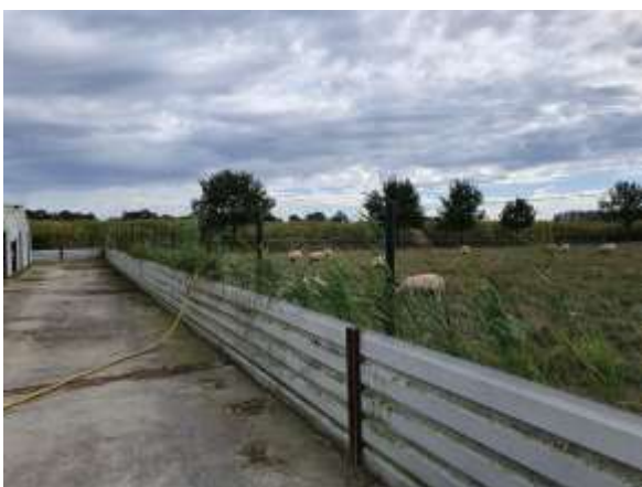
Omheining achter op locatie (Zuidkant)
