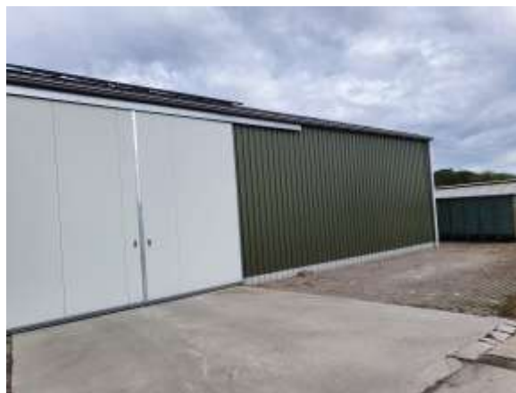
Loods achter op terrein.
