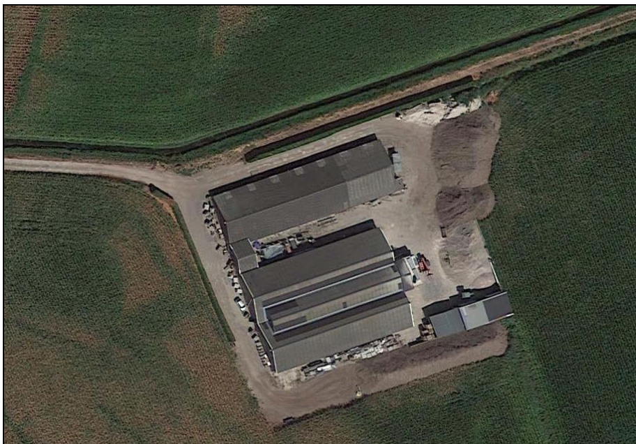
Figuur 2: Luchtfoto bedrijfslocatie
