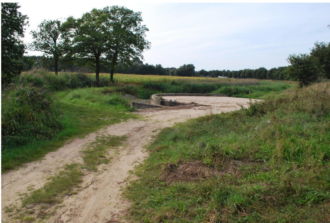
Foto 4: Ingang duiker Aa onder Zuid-Willemsvaart aan de Havenweg (rechts buiten beeld)
