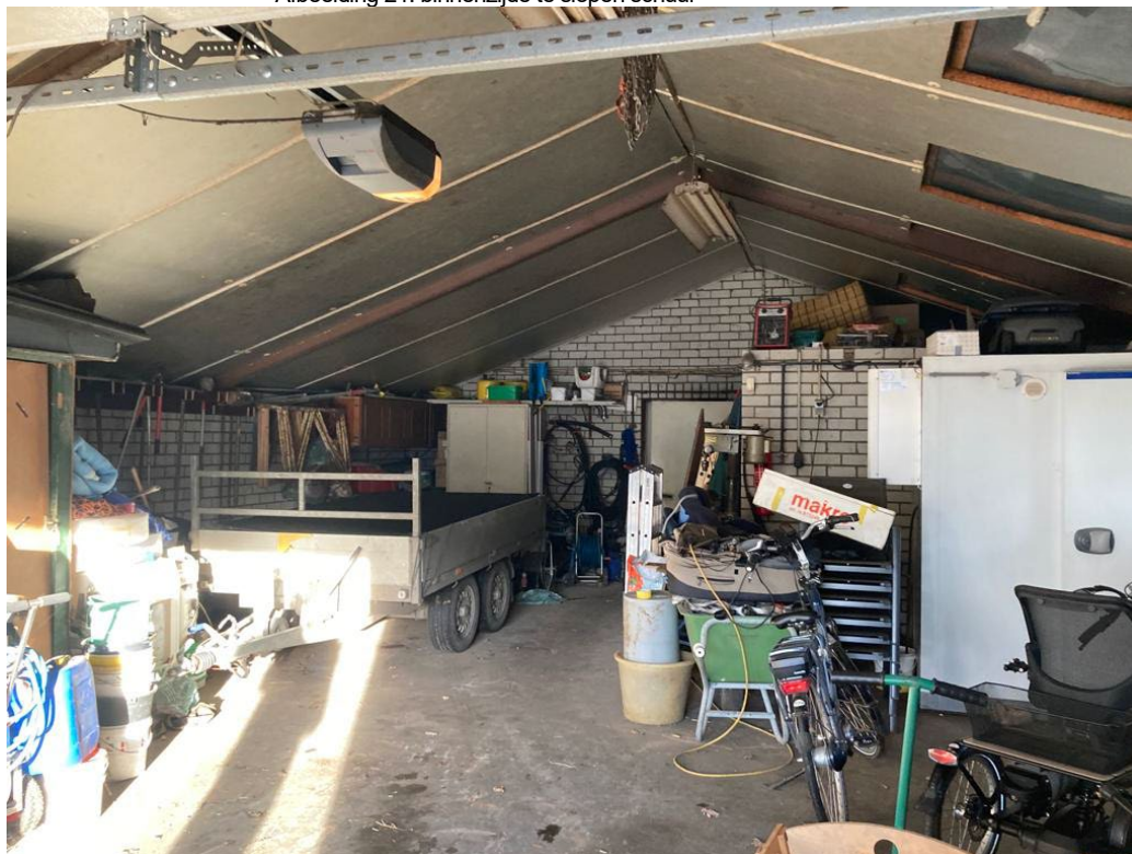
• Afbeelding 21: binnenzijde te slopen schuur
