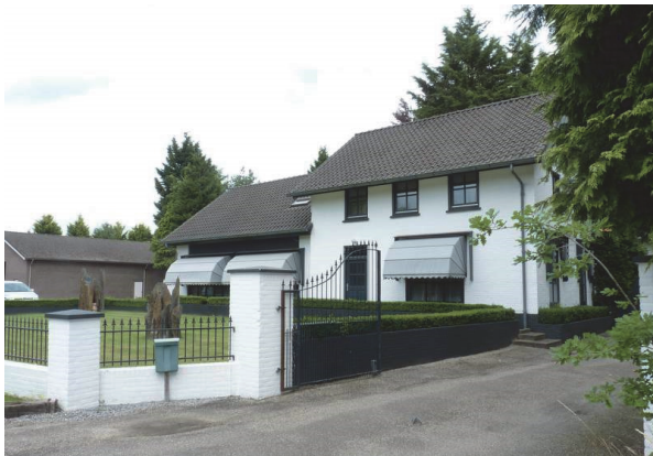
Figuur 5. De huidige bedrijfswoning met goed onderhouden tuin
