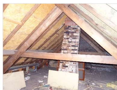
Figuur 5.4. zolder geschikt voor vleermuizen.
