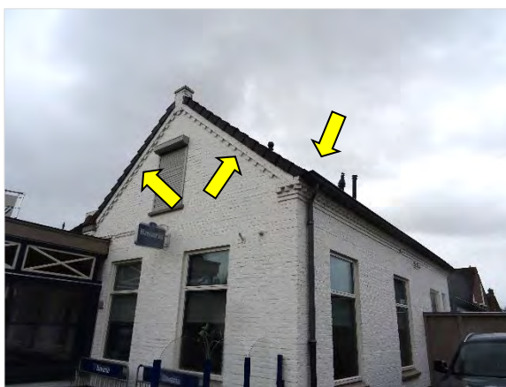
Figuur 5.1. Ruimte onder overhangende dakpannen, wat een geschikte nestlocatie voor gierwaluw en huismus vormt en dakgoot welke mogelijk toegang biedt tot ruimte onder het dak, wat een geschikte nestlocatie voor huismus vormt.
