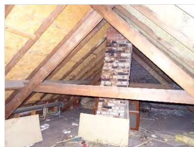
Figuur 5.4. zolder geschikt voor vleermuizen.
