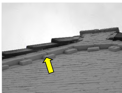
Figuur 5.3. Ruimte langs de dakranden welke toegang geeft tot ruimte onder dakpannen.
