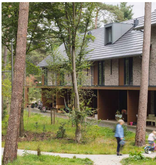
Terugliggende geveldelen grenzen aan het park
