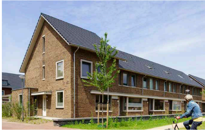
Terugliggende geveldelen en heldere gevellijn van de eerste bouwlaag
