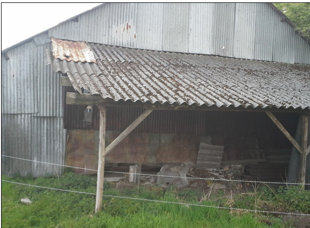
foto 2 : noordwestelijke stalling, stalen achterwand, asbest achter hoofdbouw op maaiveld
