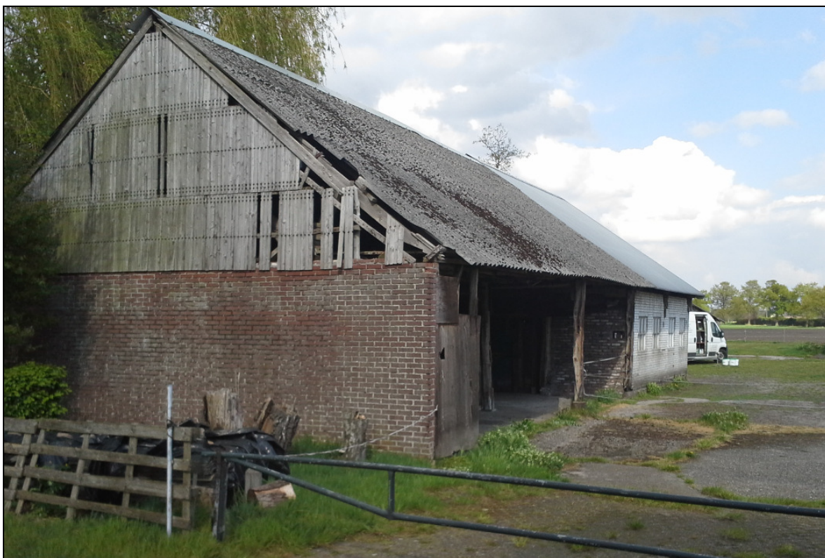
foto 1 : noordelijk stalling en opslag golfplaat achter hek
