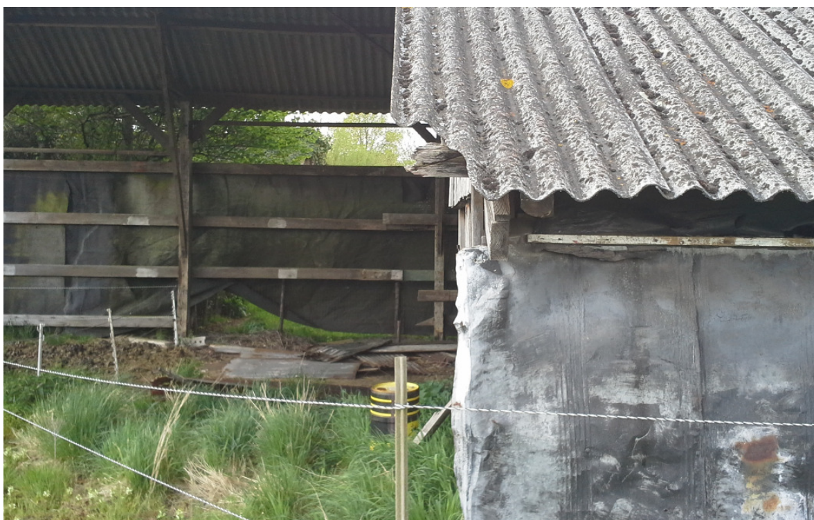
foto 6: plaatmateriaal in loods
