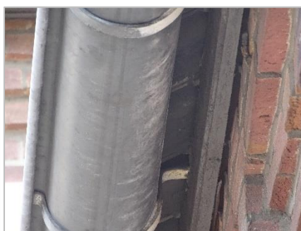
Foto 6: Aansluiting dakgoot.
