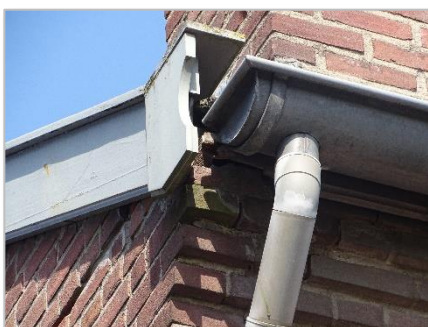
Foto 11: Aansluiting dak en dakgoot.
