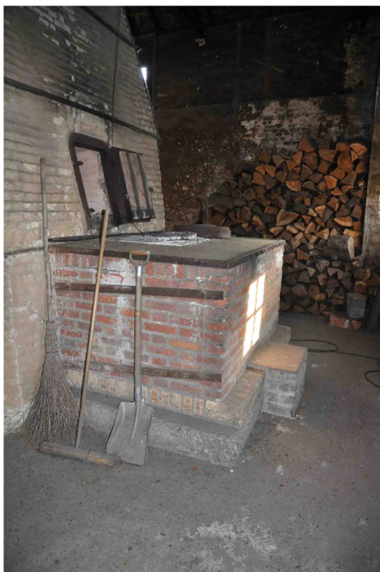
35 de opnieuw gemetselde stookopening van de oven
