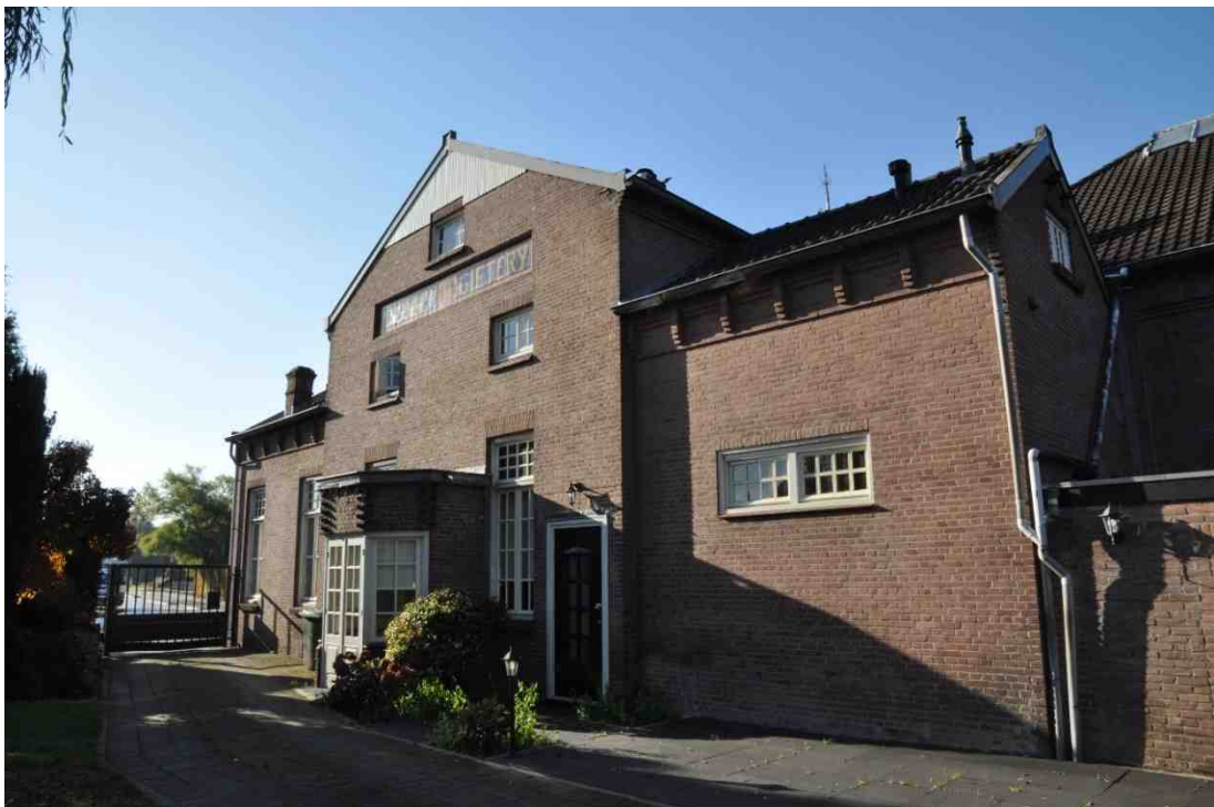
20 de oostelijke zijgevel van het bedrijfsgebouw, later omgebouwd tot woning
