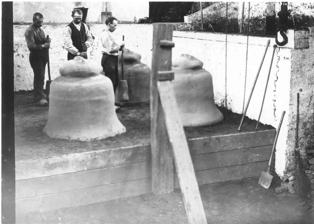
17 foto 1916. Gietkuil klokkengieterij Petit & Fritsen. De vormmallen van de te gieten klokken worden met zand aangestampt. Aan de open voorzijde van de gietkuil worden successievelijk de schotbalken aangebracht.
