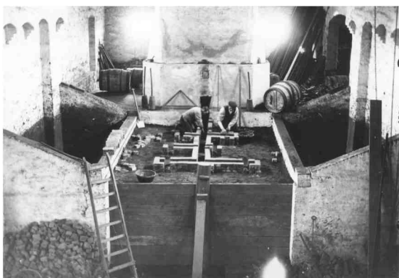
18 foto 1916, Klokkengieterij Petit & Fritsen. De gietkuil is geheel opgevuld met zand en de gietkanalen zijn aangebracht. Daarachter de gietmond van de hoger gelegen smeltoven. Aan weerszijden van de gietkuil de lege zandbakken.
