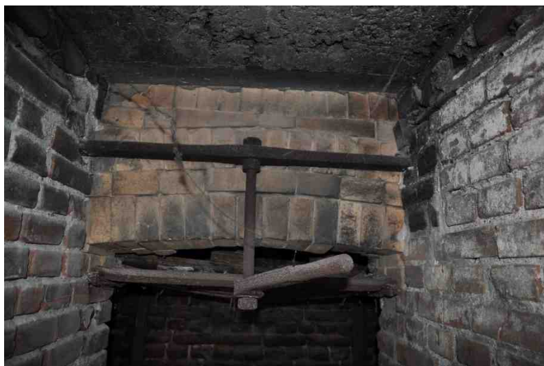
32 westelijk luchtkanaal met asrooster en in vuurvaste stenen gemetselde onderzijde van de vuurhaard. Daarboven liggende vloer in gewapend beton.
