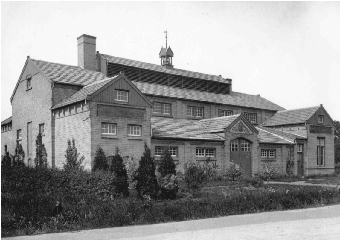
7 ongedateerde foto genomen tussen 1906 en 1923. Voorgevel en westgevel vanuit zuidwesten.
