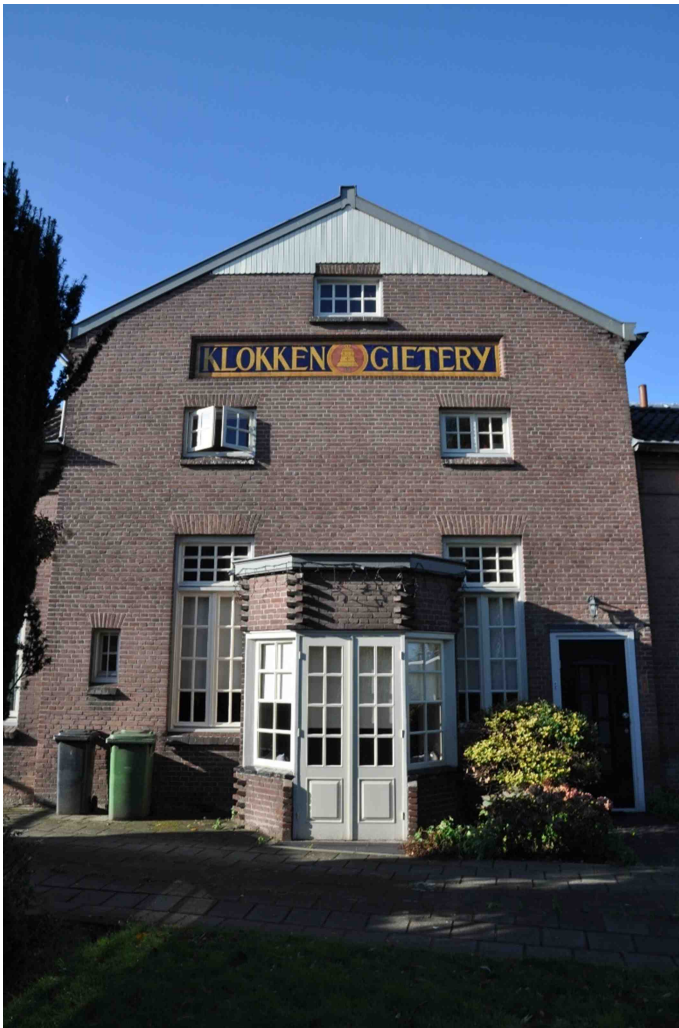
29 de oostelijke zijgevel. De erker en toegangsdeur aan de rechterzijde op de begane grond zijn later aangebracht
