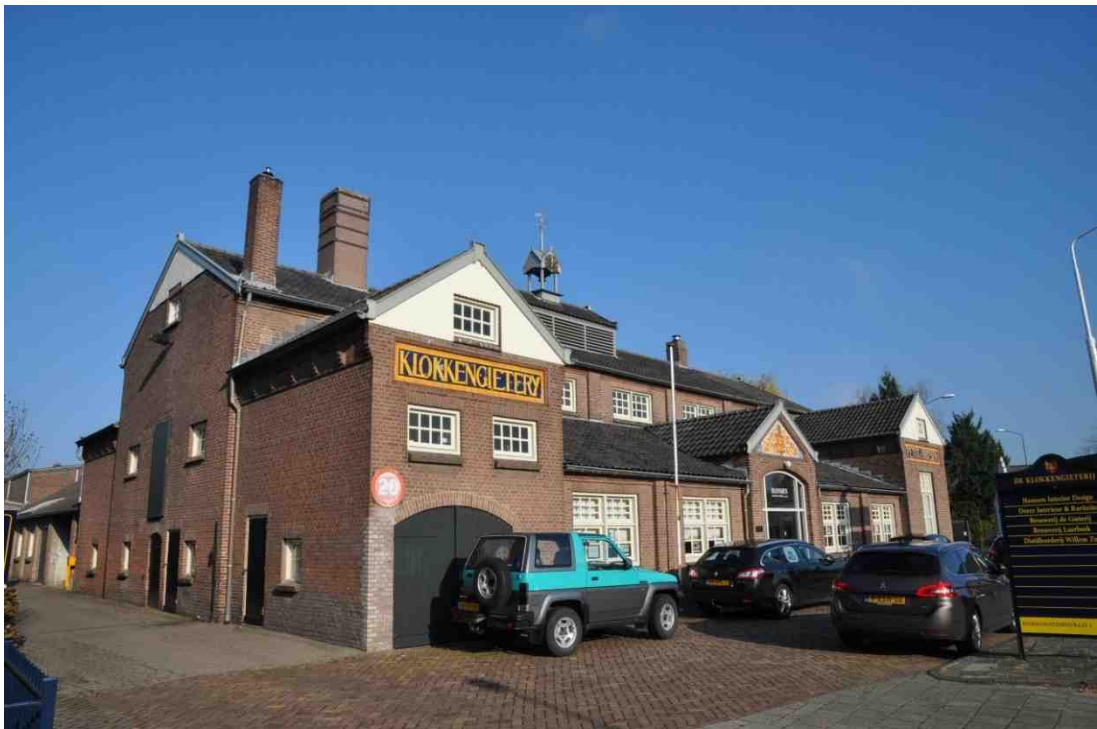
19 de voorgevel en westelijke zijgevel van het gebouw uit 1906
