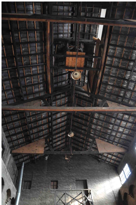
38 de kapconstructie, gezien naar het oosten
