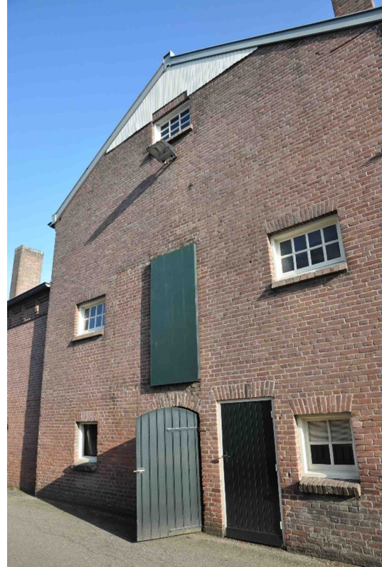
26 de westelijke zijgevel. De laadopening voor de vuurhaard op de eerste verdieping is met een later aangebrachte aftimmering dichtgezet.
