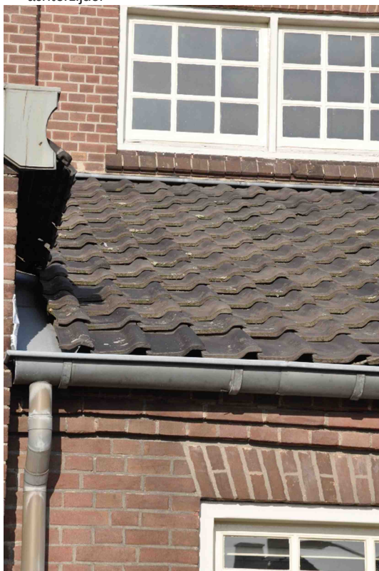
27 dakpannen type 'Tiefa'. Oorspronkelijk lagen er muldenpannen op de daken.
