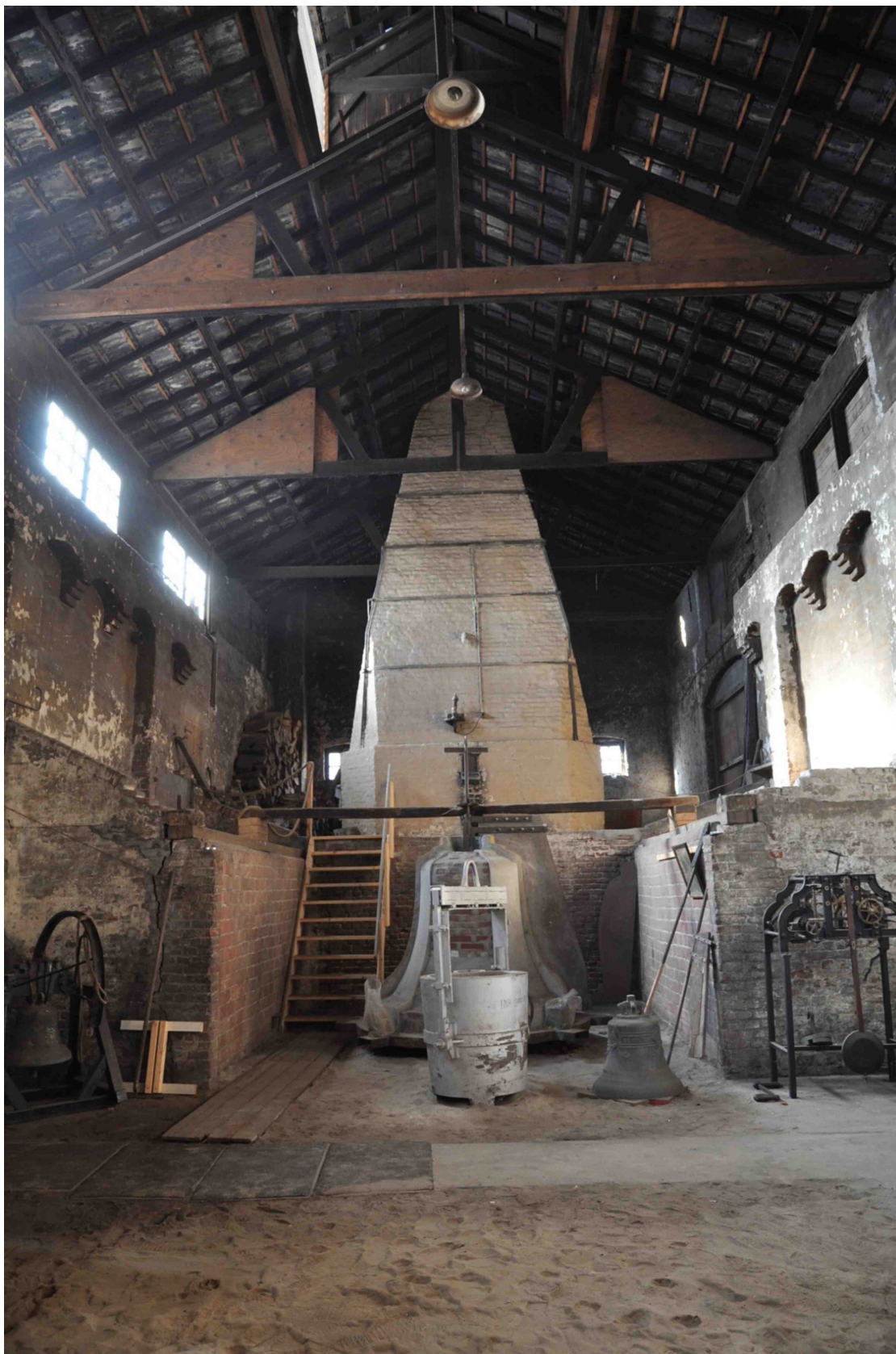
30 interieur van de giethal met zicht op de oven en de gietkuil
