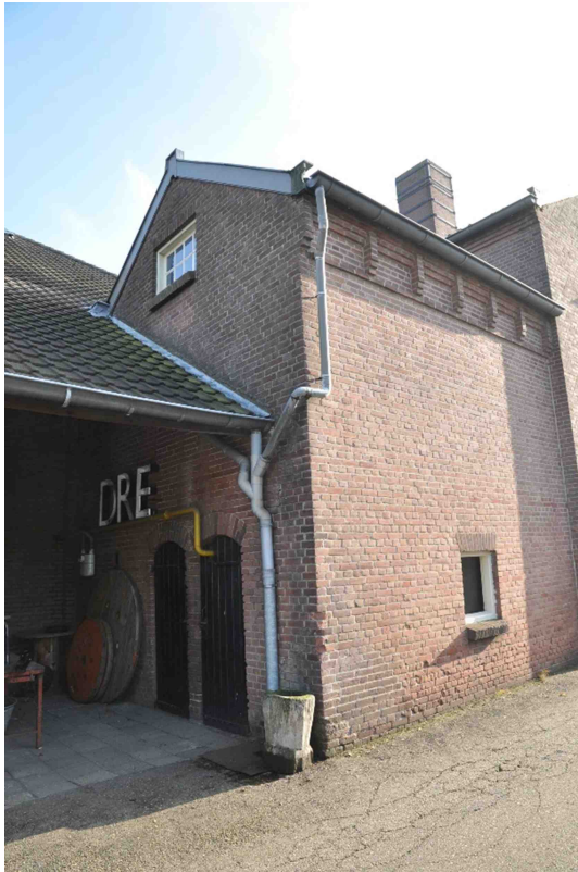
25 de achtergevel van de westelijke vleugel met de deuren die toegang bieden tot het luchtkanaal en bergingen. Links het zadeldak van de latere aanbouw aan de achterzijde.
