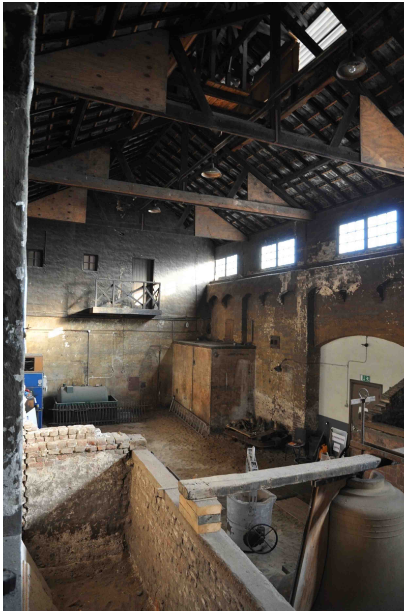
31 fabriekshal met hoog middenschip is opgezet vanuit een collonade van muurpijlers met een uitkragend booggries. Daarboven de kraanbaan met lichtbeuk en dakconstructie bestaande uit later verstevigde spanten, gordingen en daksporen. Er is geen dakbeschot waardoor de dakpannen vanuit de onderzijde zichtbaar zijn. Aan de linkerzijde een later dichtgezette centrale hoofdpoot. In de gietkuil staat een mal voor het gieten van een klok. Aan weerszijden de nu lege zandbakken. Verder zicht op de oostelijke binnengevel waartegen later een toiletgroep is gebouwd die toegankelijk is vanuit de voorbouw. Een trap om de verdieping van de oostvleugel te bereiken is niet meer aanwezig.
