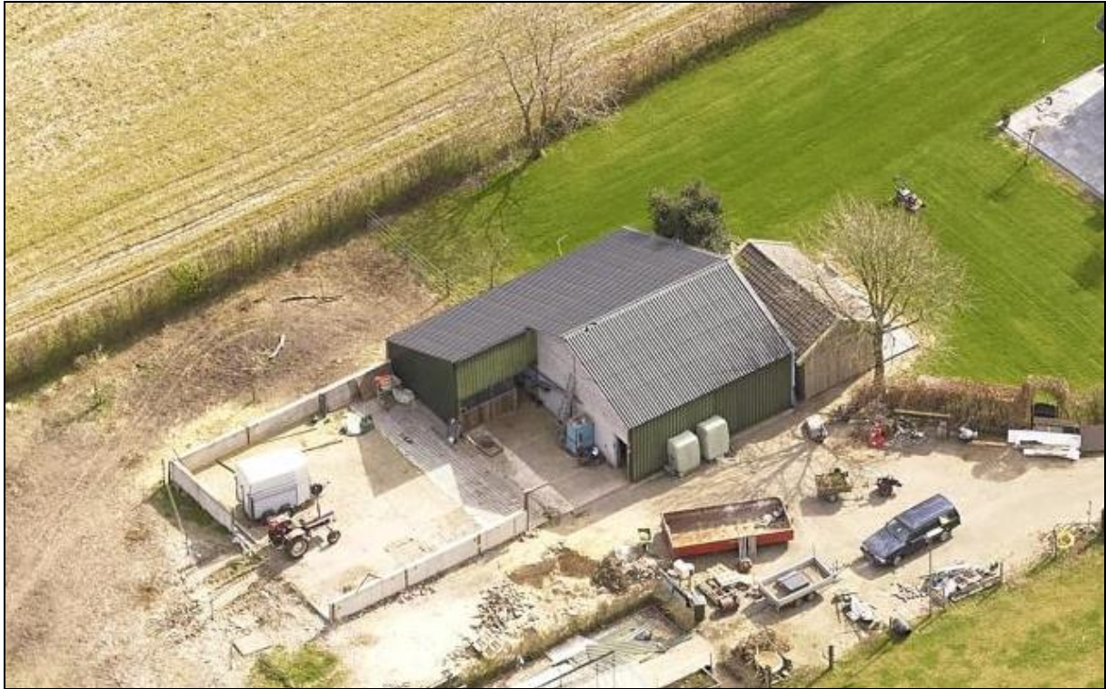
Figuur 7: Luchtfoto met de loods
