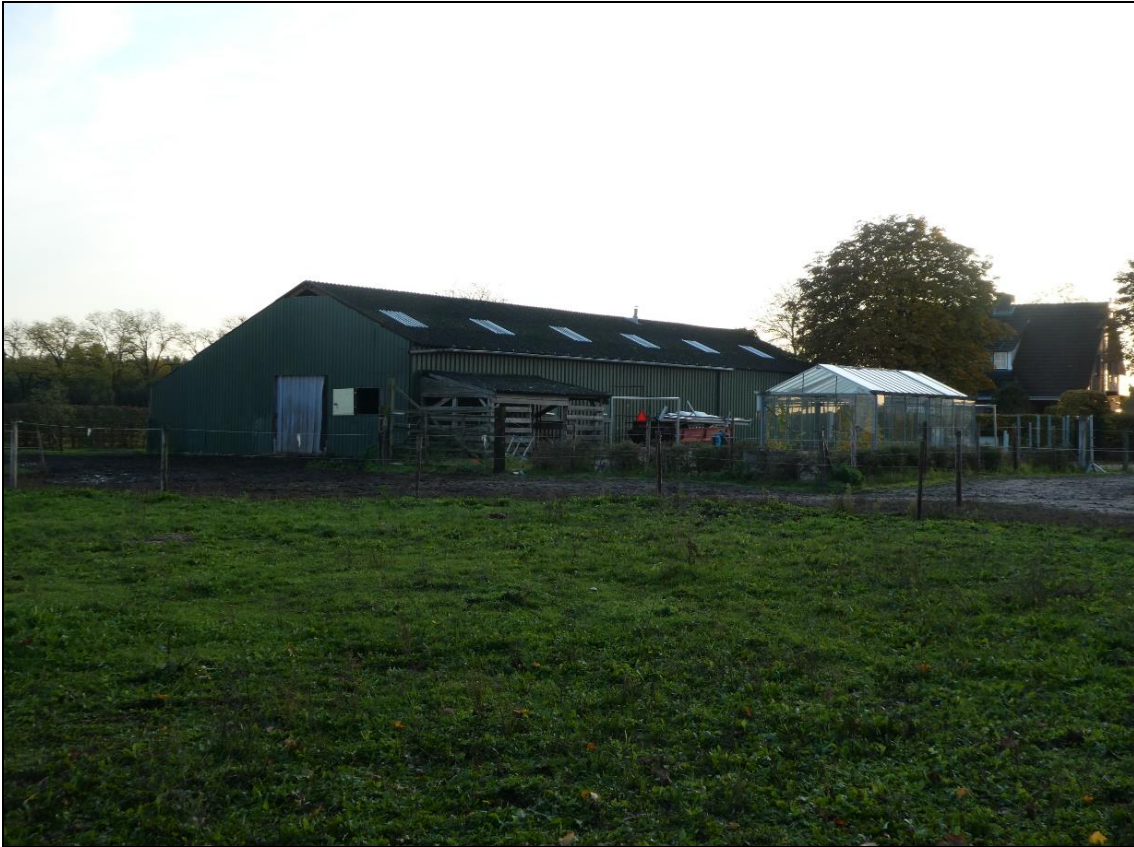
Figuur 6: Loods op het achtererf, de loods is reeds verkleind tot 120 m 2
