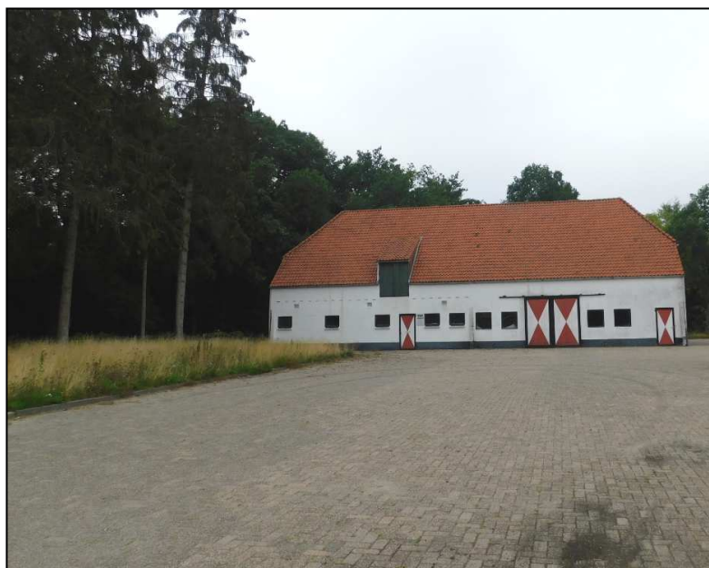
Figuur 9: Foto van de schuur aan Valkenswaardseweg 46a met aan de voorzijde een klinkerverharding
