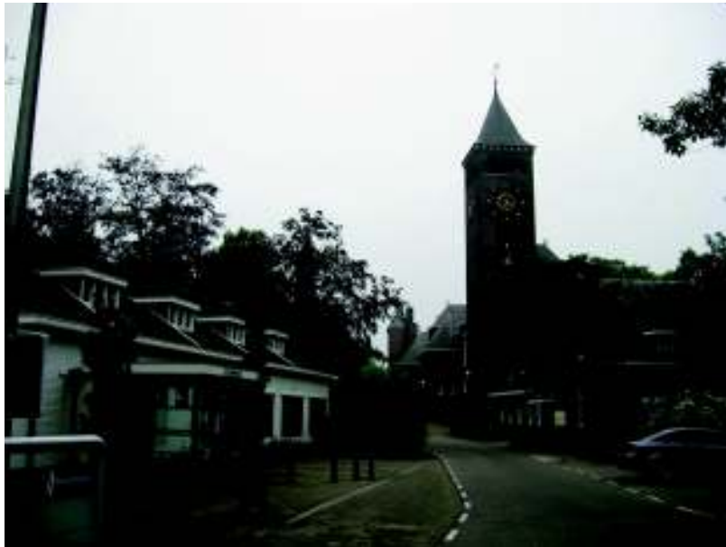
Figuur 2.1. De kerk, centraal gelegen op het Providentia-terrein.
