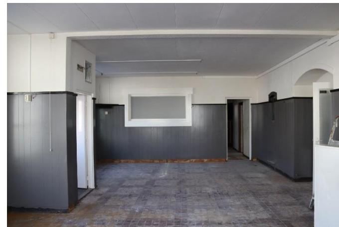
Afb. 11 Impressie van de begane grond, gezien richting het noordoosten. De tegelvloer is kenmerkend voor de bouwperiode. Rechts de toeg naar de gang die café en zaal verbindt.
