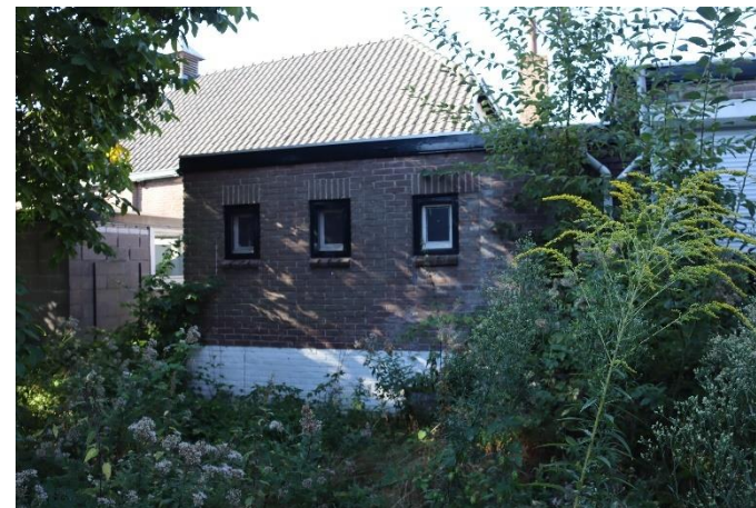
Afb. 48 De achtergevel, gebouwd in 1946-1950.
