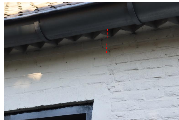
Afb. 20 Detail van de muizentandlijst. Het rechter deel is oorspronkelijk, links van de stippellijn is naaorlogs.
