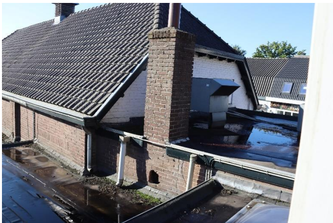
Afb. 42 De noordwestelijke kopgevel.
