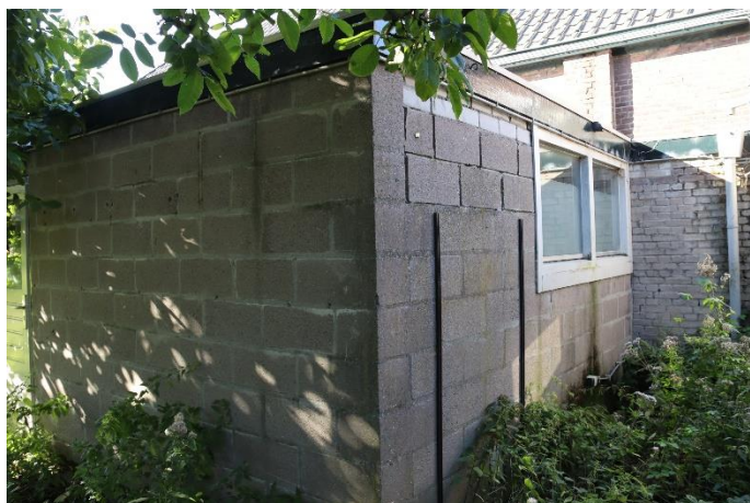
Afb. 57 In cementbetonblokken opgetrokken keukenvolume.
