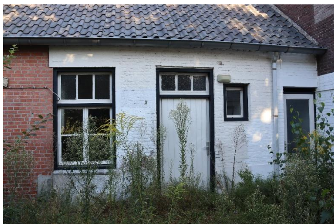
Afb. 18 De achtergevel wordt gevormd door muurvlakken uit diverse bouwperiodes.
