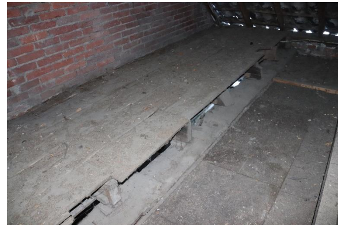
Afb. 34 Op de muur tussen de woonruimten en de onderdoorgang ligt een hergebruikte moerbalk.
