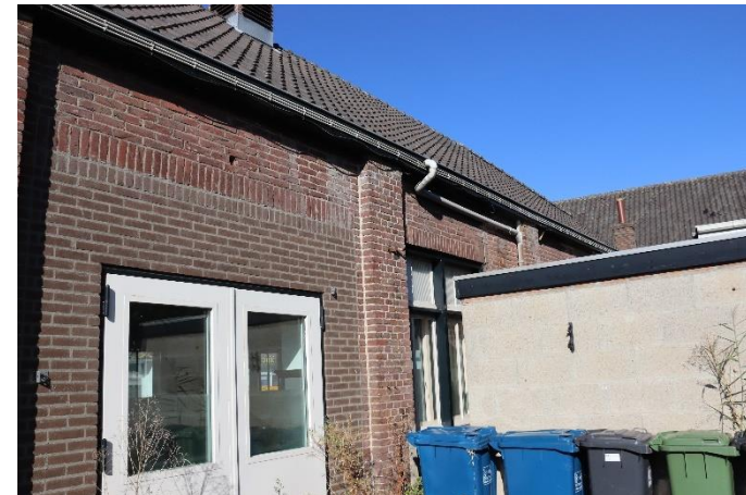
Afb. 40 Nieuwe invulling travee. Rechts de aanbouw in cementbeton, die deels vóór het venster ligt.
