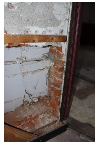
Afb. 28 Sporen van oudere baksteen, gemetseld met cementhoudende mortel (hergebruikte steen).
