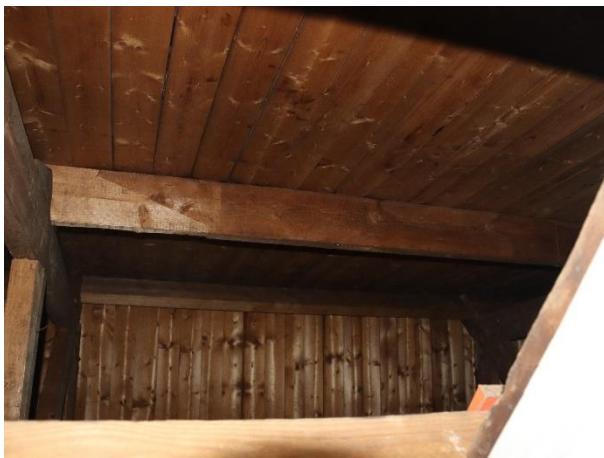
Afb. 16 Blick op zolder via luik. Kap bestaande uit verbeterde Hollandse spanten en een naaldhouten beschoot.
