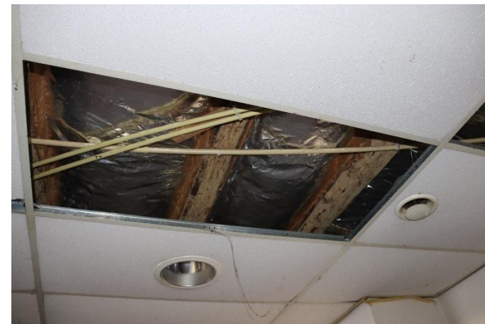
Afb. 24 Boven het systeemplafond zit een enkelvoudige balklaag, bestaande uit hergebruikte (gedisselde en gekantrechte) balken. Deze liggen parallel aan de straat (aanwijzing voor hergebruik).
