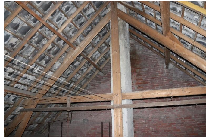
Afb. 33 Zijgevel van Nieuwendijk 1, waarin de gordingen en nokbalk zijn gelegd. Verbeterd Hollands spant.
