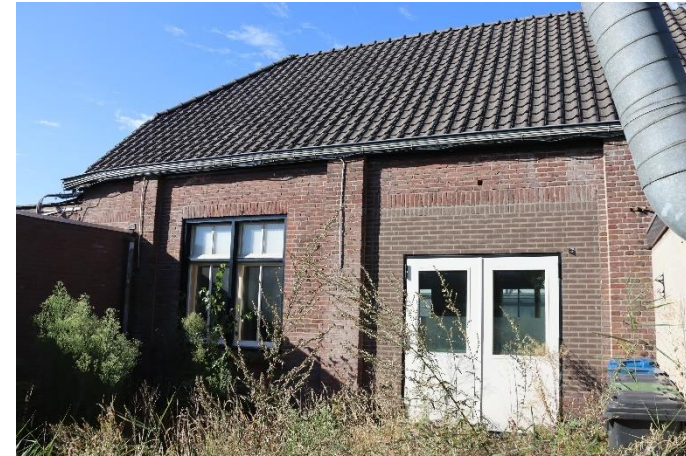
Afb. 39 Achtergevel, linker traveeën. In het rechter travee zit een nieuwe invulling. Links een vrij jonge aanbouw die de hoek van de zaal omkapselt.
