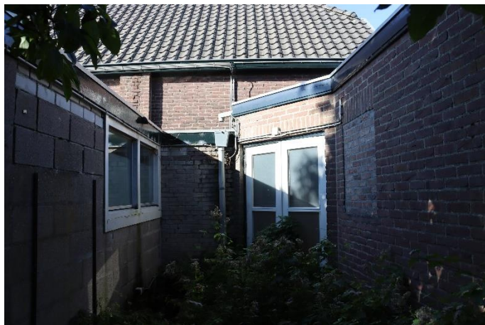
Afb. 50 Rechts de zijgevel van het tussenvolume met dichtgezet venster. De afgeschuinde hoek maakt hier deel van uit.
