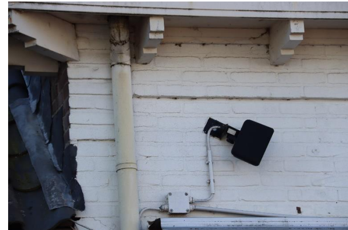
Afb. 6 Detail van de bakgoot en de bescheiden uitkragende schouder.
