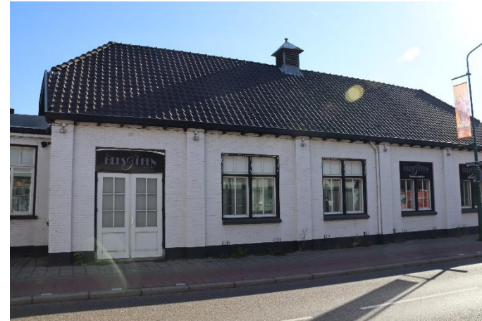
Afb. 35 De zuidwestelijke gevel van de harmoniezaal. De gevelindeling is oorspronkelijk (circa 1932)
