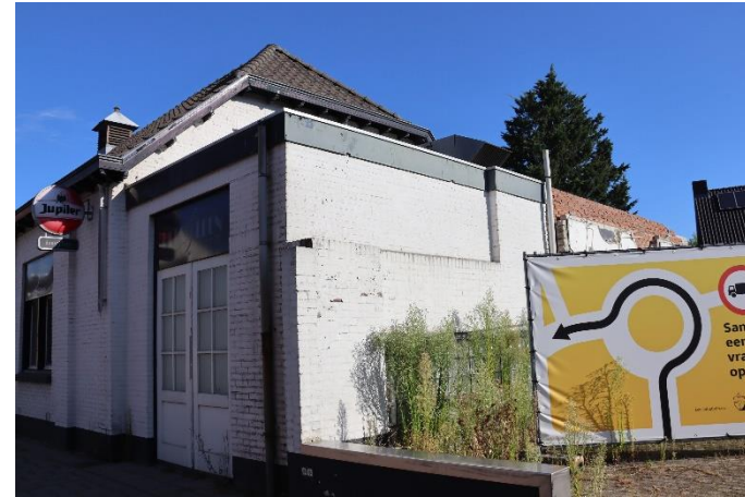
Afb. 55 Aanbouw tegen de zuidoostgevel, gebouwd rond 1980.
