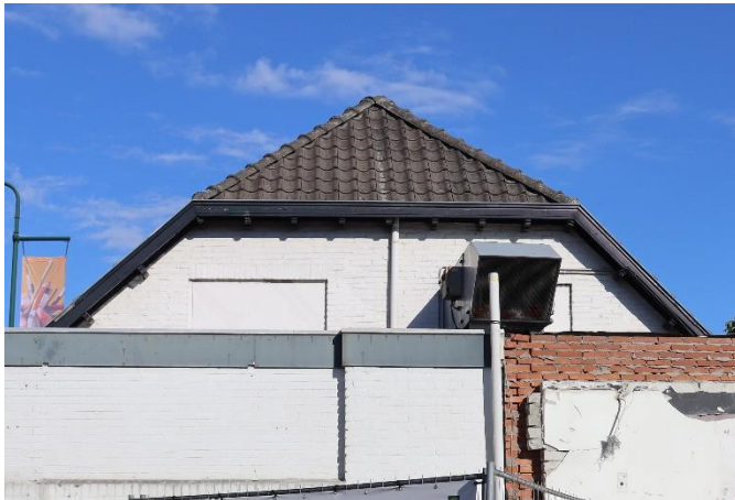
Afb. 38 De dichtgetimmerde vensters onder het wolfseind (zuidoost zijde). De achterliggende zolderruimte is niet toegankelijk.
