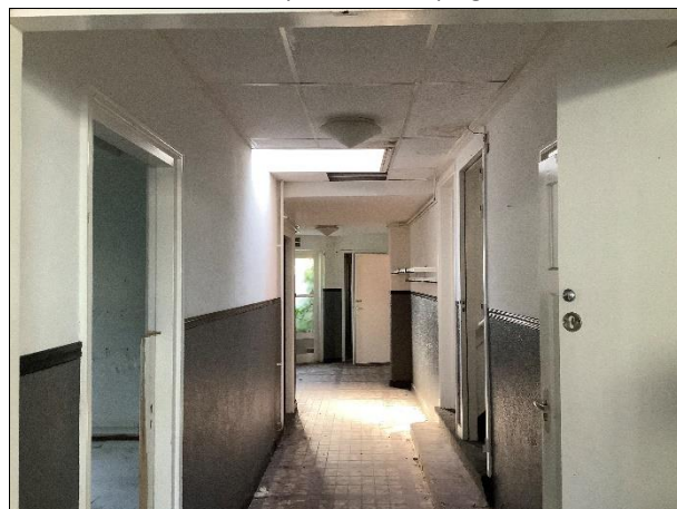
Foto 4 Foto van het leegstaand gebouw
