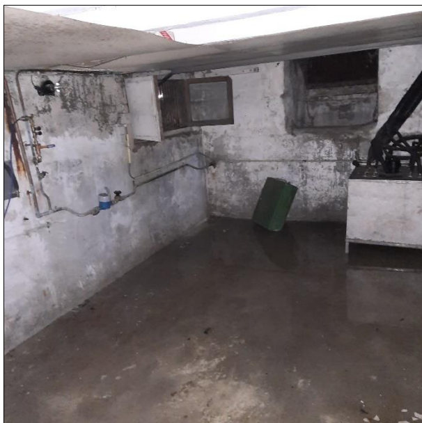
Foto 1 Foto van de kelder
