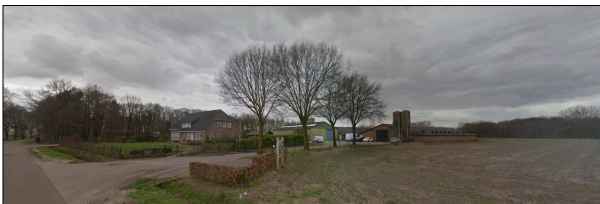
Figuur 8: Foto van de planlocatie in de huidige situatie, locatie Paaldijk 4 bij de noordelijke inrit
