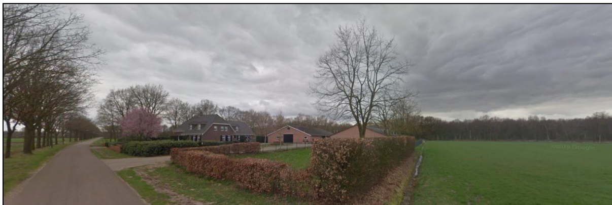
Figuur 10: Foto van de planlocatie in de huidige situatie, locatie Paaldijk 10 bij de noordelijke inrit
