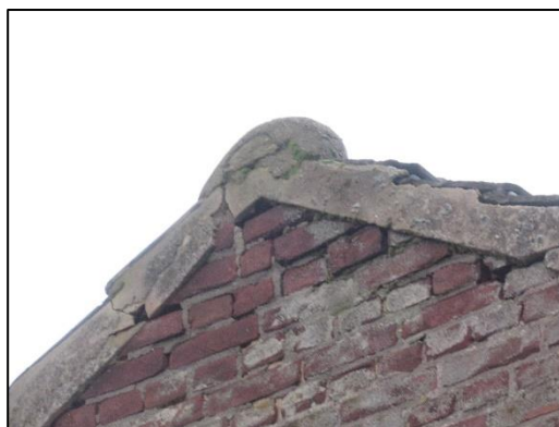
Foto 12. Mogelijkheden voor verblijfplaatsen van vleermuizen in noordzijde woning
