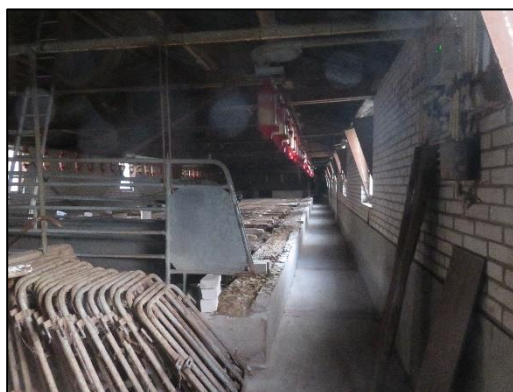
Foto 10. Binnenzijde varkenstallen (eerste verdieping)
