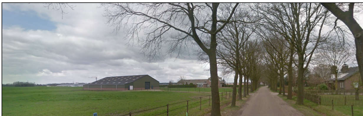
Figuur 8: Beeld van de loods binnen het plangebied, gezien vanaf Chijnsgoed
