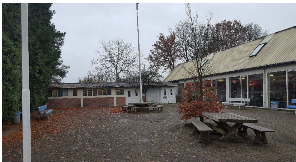
Figuur 6: Aan de linkerzijde van de foto: de werkplaats van Joppen Motoren, deze is gedurende de hagelstorm van 23 juni 2016 zwaar beschadigd geraakt
