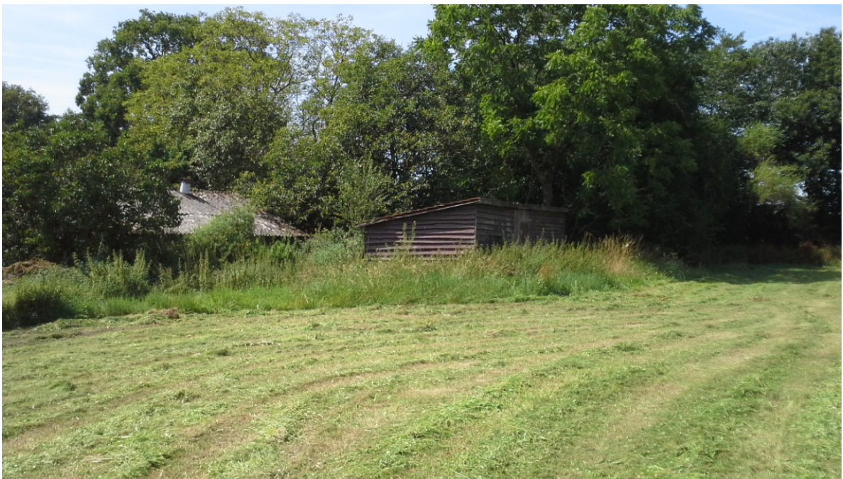
schuren terreindeel E (rechts) en zuidelijk terrein (links)
