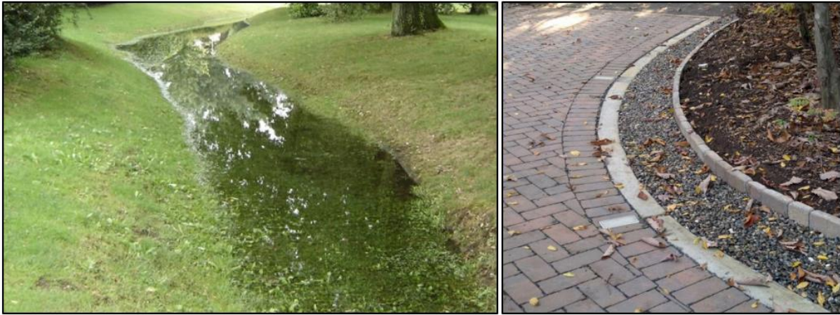
Figuur 13: infiltratievoorzieningen op maaiveldniveau
