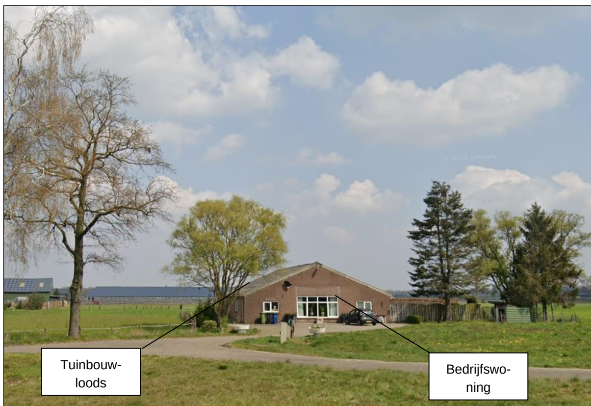
Figuur 5: Huidige situatie binnen het plangebied. Aan de voorkant (zuid-west kant) is de inpandige bedrijfswoning gelegen. Aan de achterzijde ligt de tuinbouwloods.
