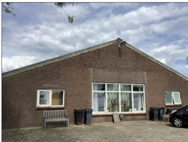
Foto 1 Foto van de zuidzijde van de bedrijfsloods
