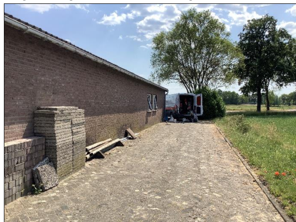
Foto 4 Foto van de westzijde van de bedrijfsloods
