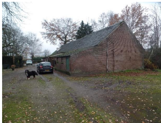
Woonboerderij gezien aan de achterkant
