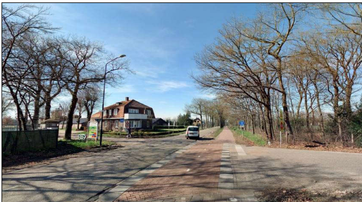
Figuur 10 : Foto van de huidige kruising Kloosterlaan met de Heezerweg en Albertlaan, gezien vanaf de Heezerweg
