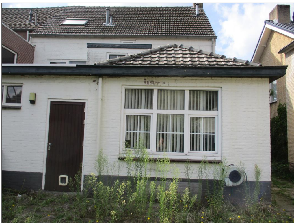
Figuur 2 De oostzijde van de bebouwing op de planlocatie.
