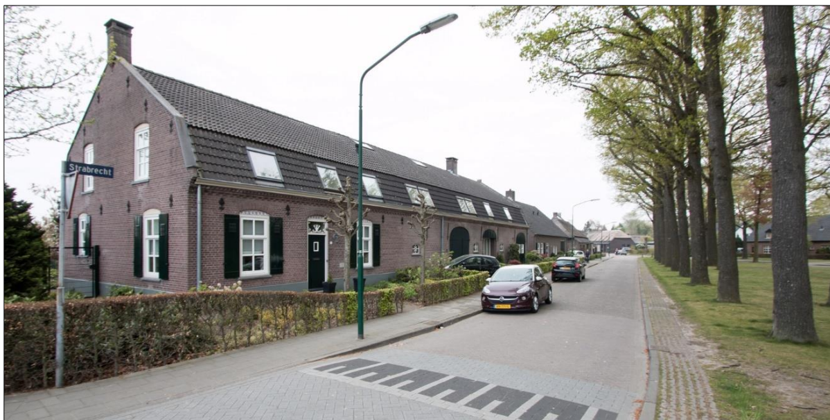
Afb. 2.16 De bebouwing aan de noordzijde van het Strabrechtspleinje met op de hoek (voorgond) een in 1906 op oudere boerderijplaats gebouwde boerderij, die in hoge mate beeldbepalend is.
