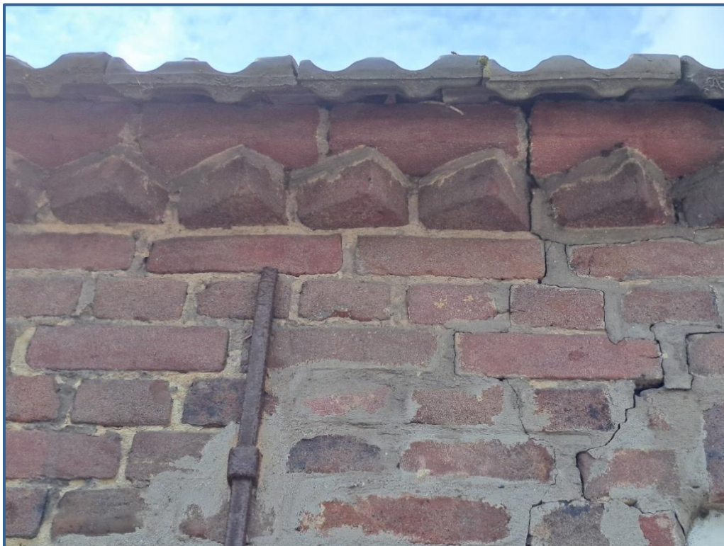
Onderkant van de dakrand van de twee-onder-één kapwoning.
