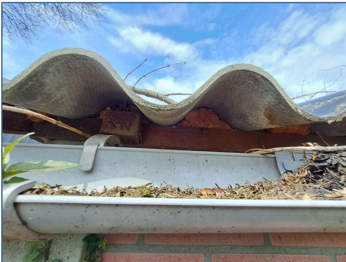
Met purschuim afgesloten openingen onder de golfplaten van de aanbouw van het woonhuis.
