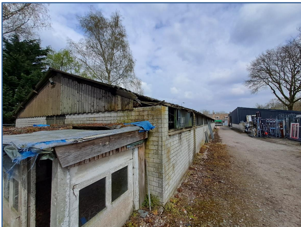
Zicht op de westgevel van de oude schuur.
