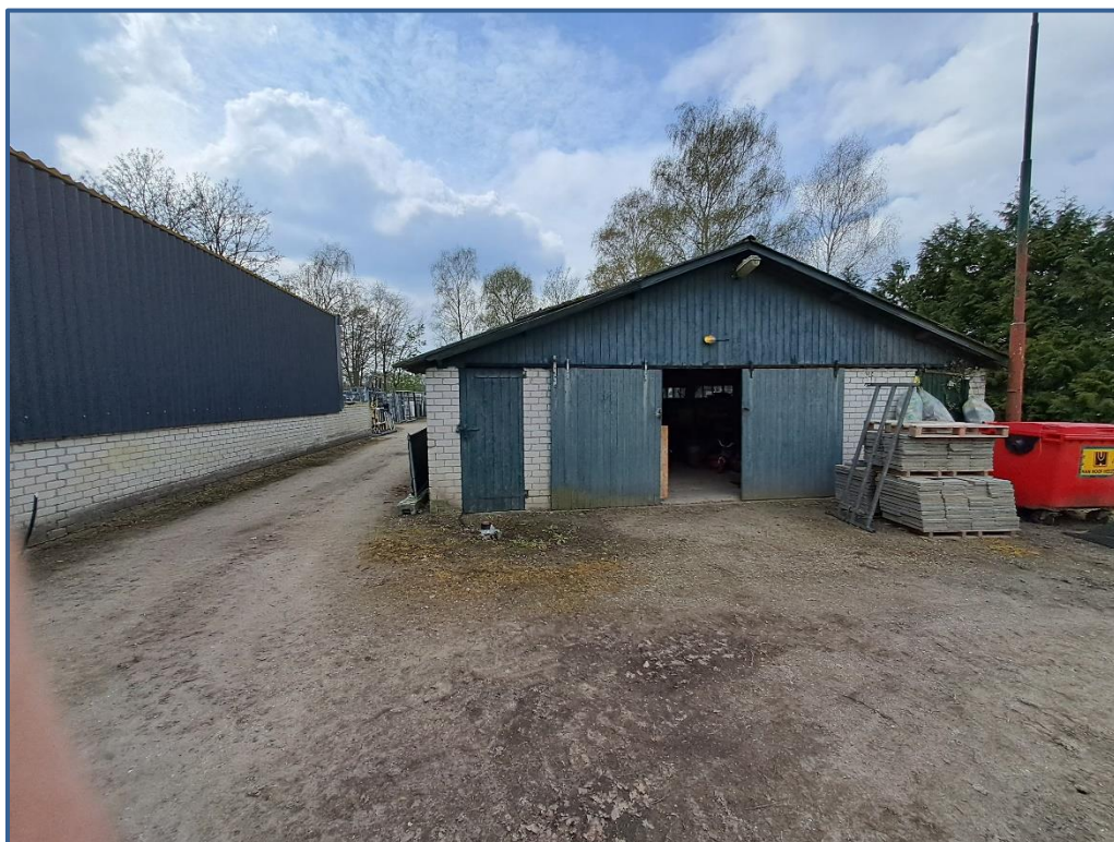
Zicht op de oostgevel van de oude schuur.
