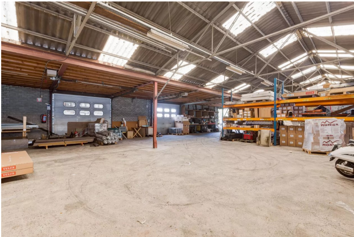
Figuur 23: Binnenkant loods 1
