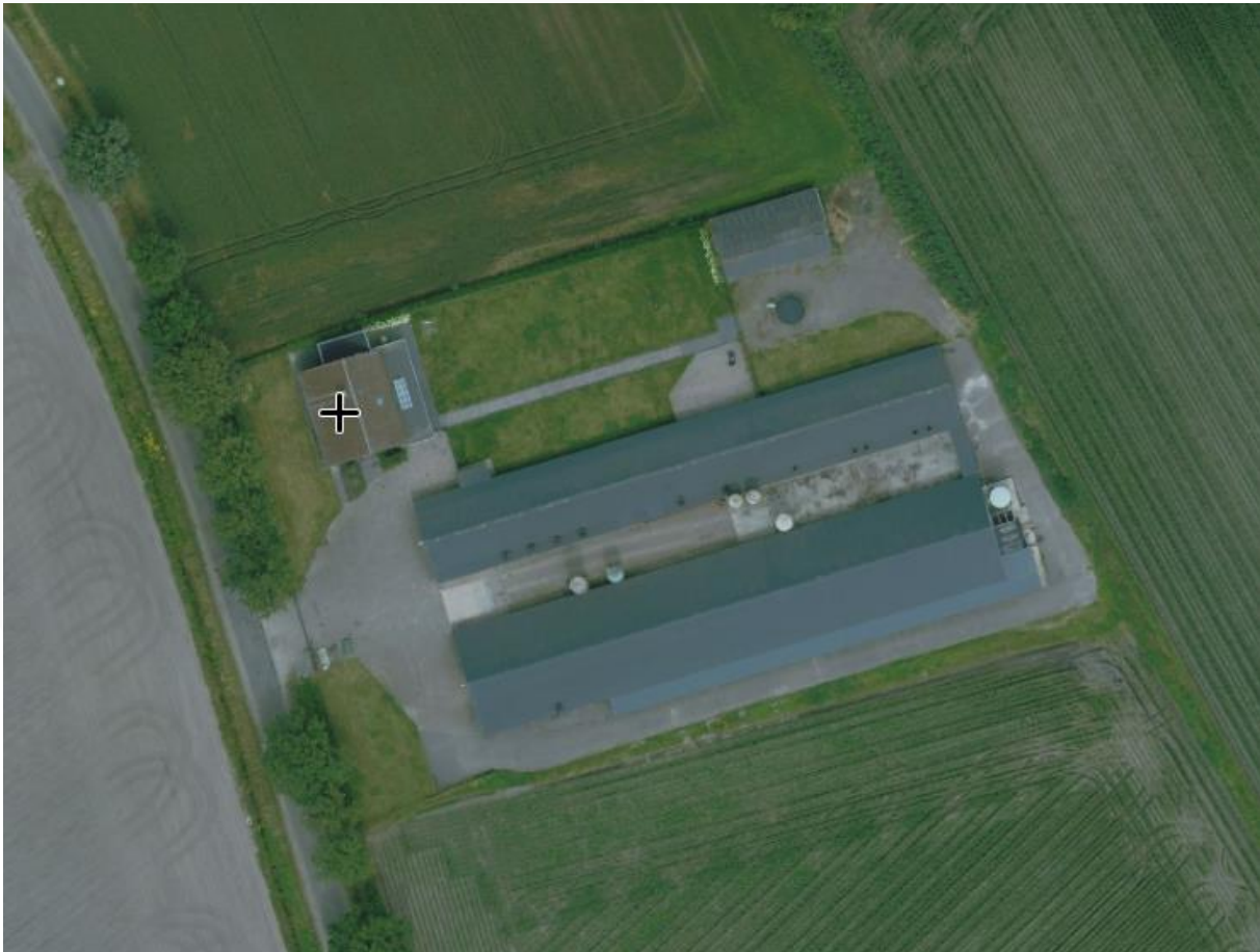
Figuur 2.1.1: Luchtfoto locatie Renheide 8, Leende (bron: streetsmart.cyclomedia.com).
