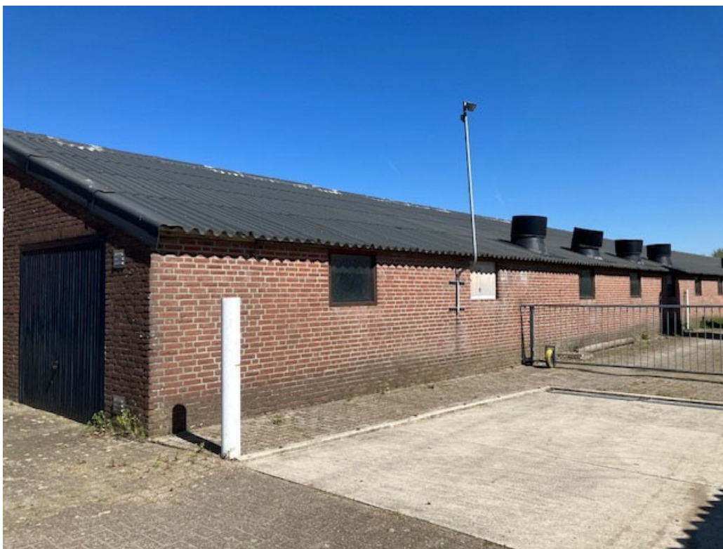
• Afbeelding 6: Zijkant te slopen stallen
