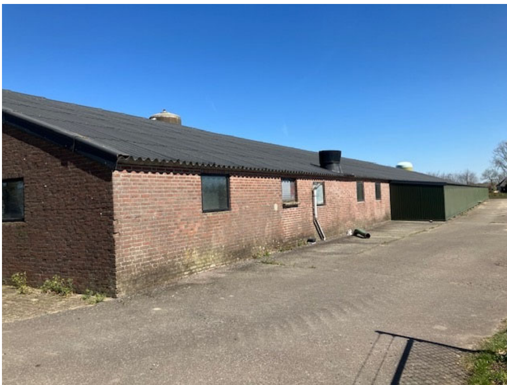
• Afbeelding 10: Zijkant te slopen stal
