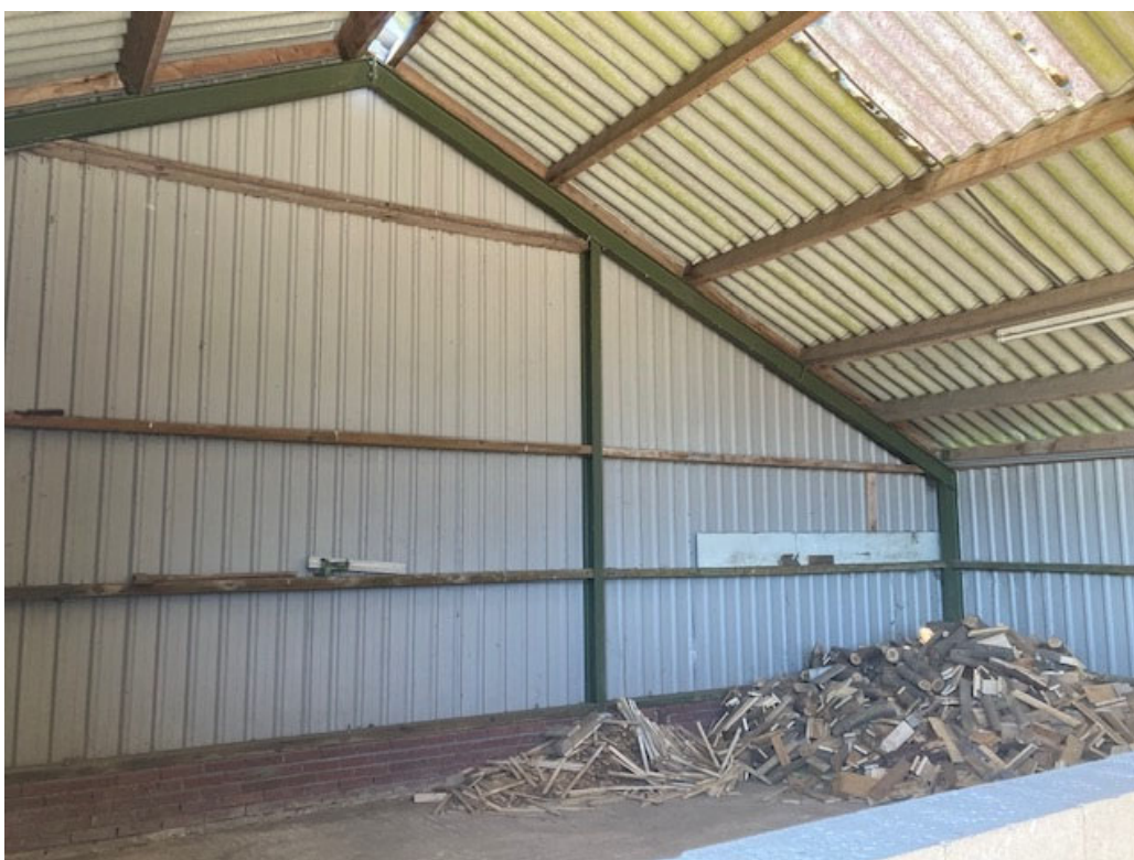
• Afbeelding 16: Te slopen veldschuur
