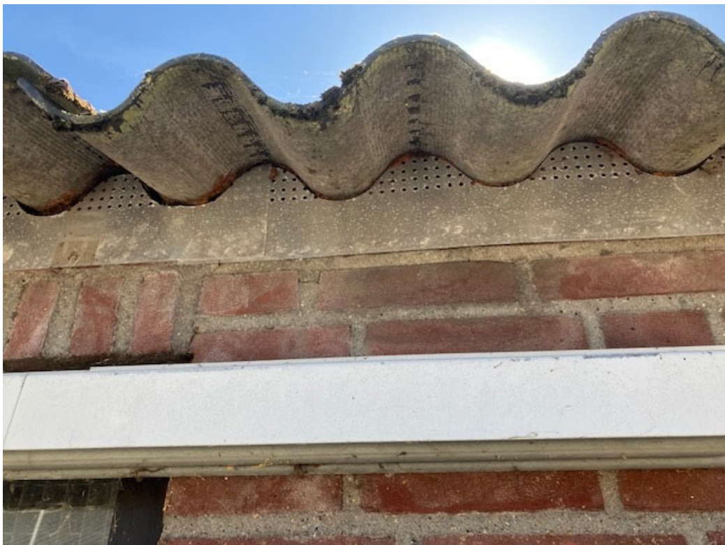
• Afbeelding 8: Dakaansluiting geheel dicht
