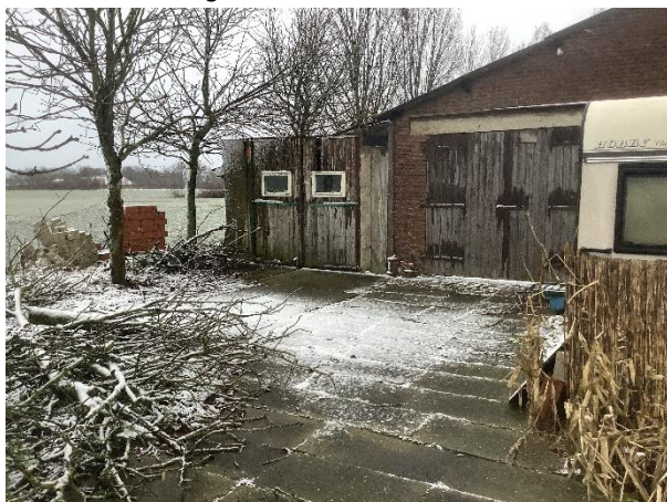
Foto 3 Foto van het zuidelijk gedeelte van het bijgebouw
