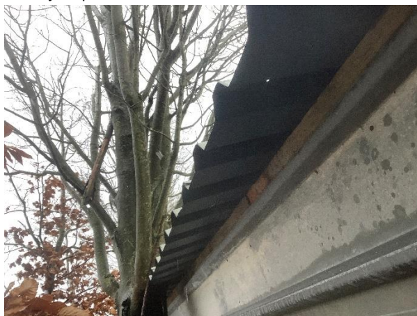
Foto 4 Foto van de dakconstructie van de aanbouw
