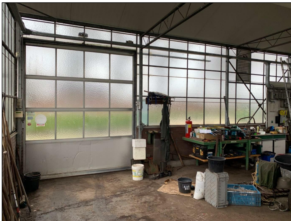
Figuur 14: Foto's binnenkant bedrijfsgebouw aan de voorzijde van de kassen
