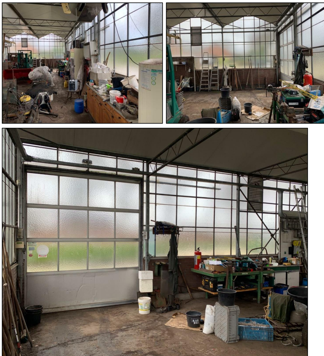
Figuur 14: Foto's binnenkant bedrijfsgebouw aan de voorzijde van de kassen
