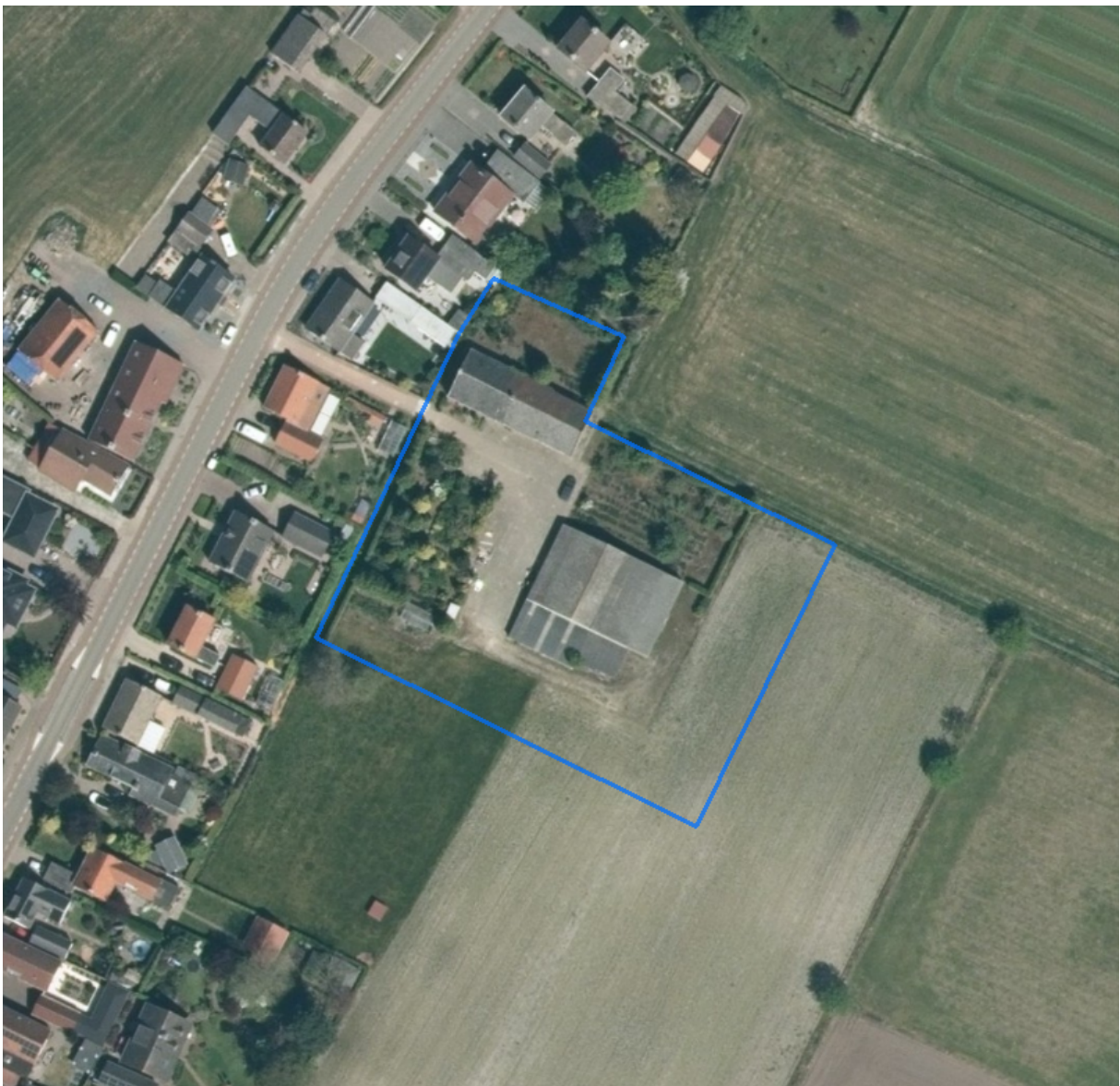
Afbeelding 3. Luchtfoto huidige situatie plangebied.
