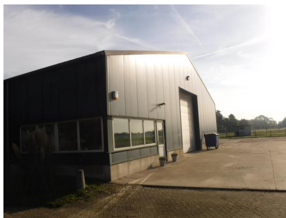
Loods: strak afgesloten profielen en windveren.
