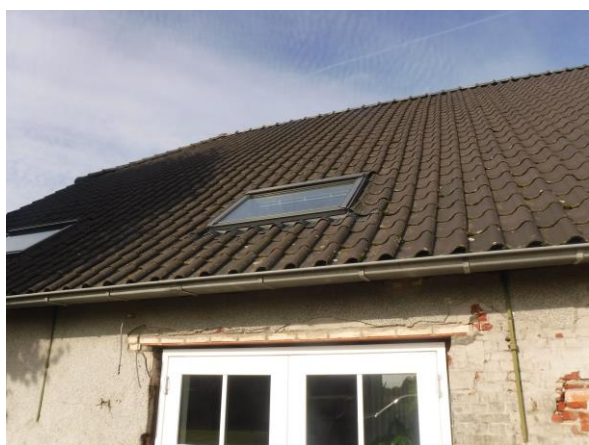
Metalen goten verhinderen het invliegen van vleermuizen aan de dakranden bij de woning.
