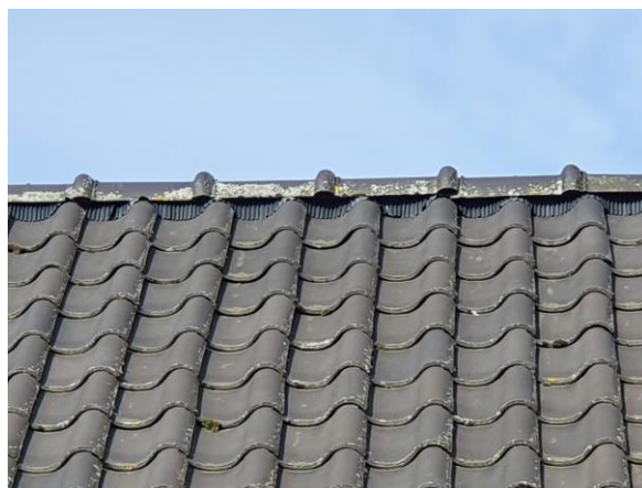
Onder pannen en rondom dakkapellen is vogelschroot aangebracht.
