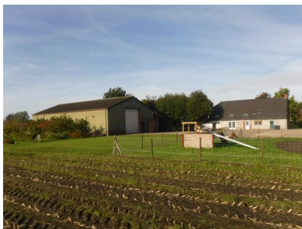
Loods en woning: damwand profielen afgedicht met damwandstoppers.
