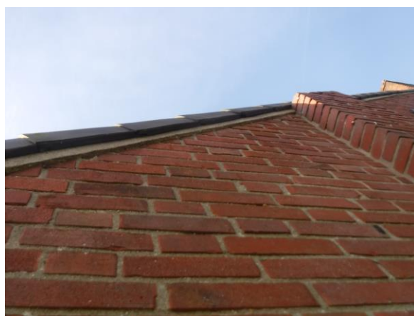
Gevelpannen afgedicht met een rand van cement. Strakke gevels: geen scheuren en gaten aanwezig.
