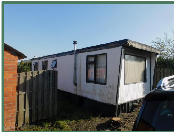
Overzicht stacaravan zuidzijde
