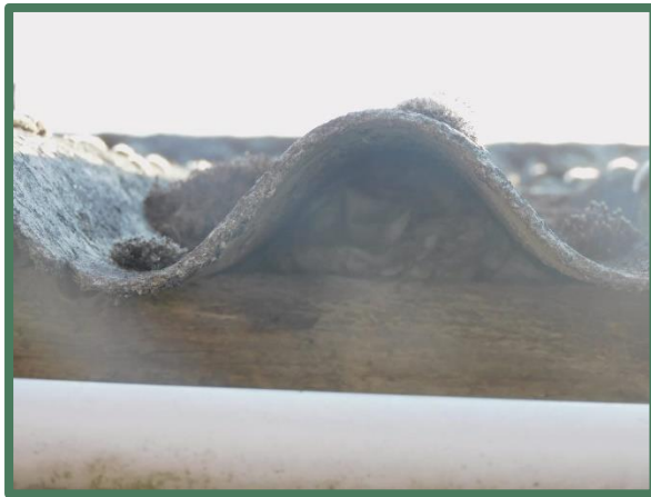
Gesloten golfplaten dak schuur
