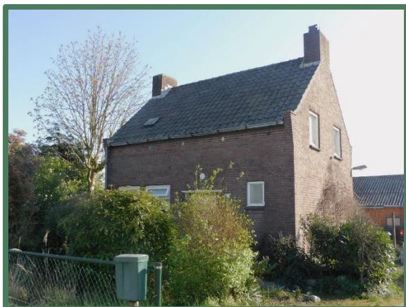
Overzicht bedrijfswoning westzijde
