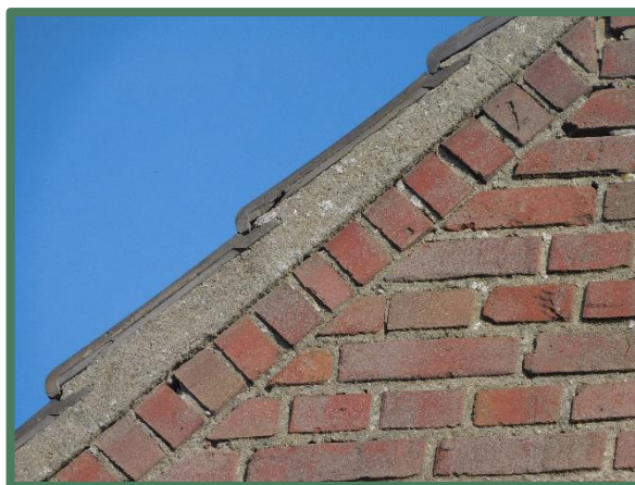
Aangesmeerde kopgevelpannen woning
