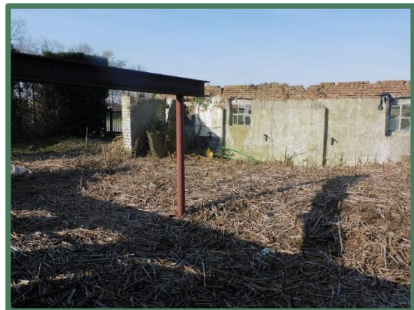
Overzicht ruïne binnenzijde
