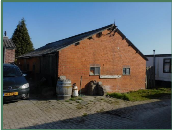
Overzicht schuur zuidzijde
