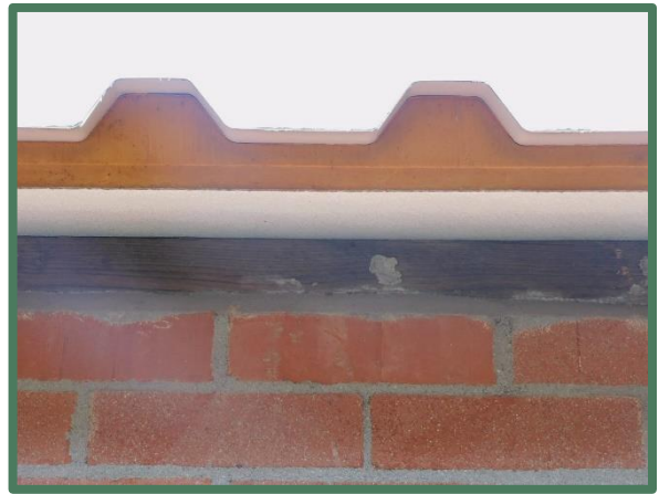
Gesloten sandwichpanelen met muurplaat loods
