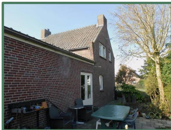
Overzicht bedrijfswoning met aanbouw noordzijde
