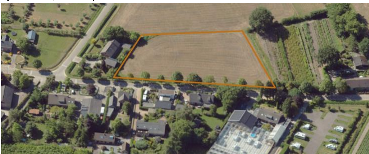
Figuur 2.3: Vogelvlucht plangebied vanaf het noorden (bron: www.cyclomedia.nl )
