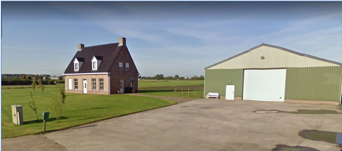
Aanzicht plangebied vanaf Palingstraat in zuidwestelijke richting
