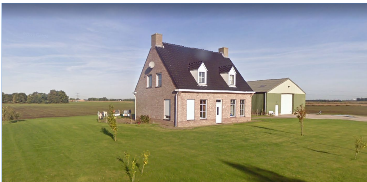
Aanzicht plangebied vanaf Palingstraat in noordoostelijke richting
