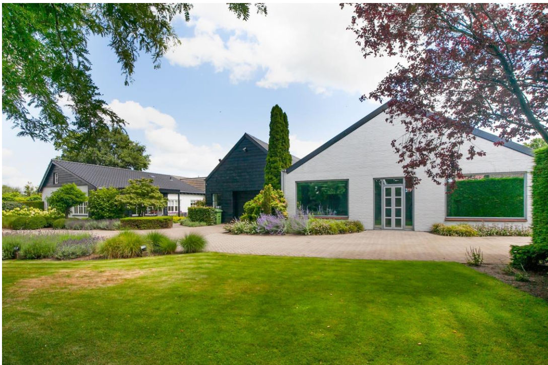
Bebouwing op het perceel Achter 't Hof 31: (bedrijfs)woning (links), bijbehorend bouwwerk bij bedrijfswoning (donker, midden), bedrijfsruimte (wit, rechts)
