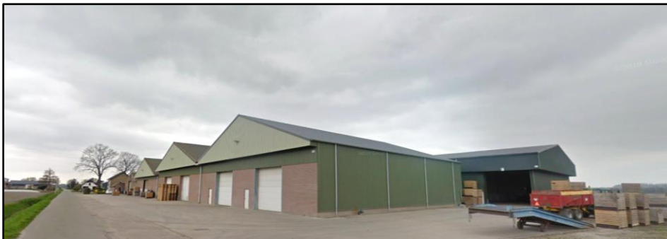
Afbeelding 6: aanzicht initiatieflocatie vanuit zuidoosten (bron: Google Streetview)
