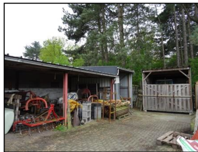
Figuur 4. Overzichtsfoto van deel van de loods (links) en tractoropslag (rechts).
