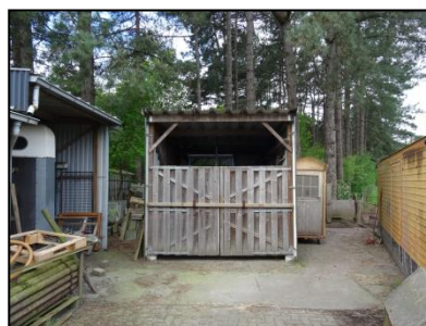
Figuur 7. De te slopen tractoropslag.
