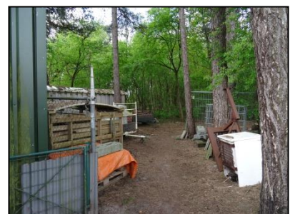
Figuur 8. Achterzijde loods aangrenzend aan bosgebied.
